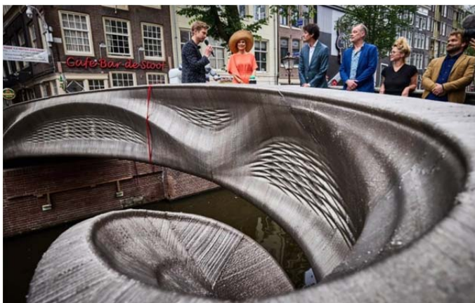
Рис. 1. Мост, сваренный роботами в Нидерландах [1]
