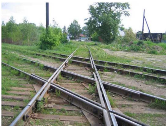
Рис. 1. Трамвайно-железнодорожные глухие пересечения: сверху – схема косоугольного железнодорожного пересечения; снизу – иллюстрации сварных сборных трамвайно-железнодорожных пересечений
